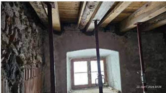
**Schwieriger Umbau:** Die Wände der alten Probsteiräume in der sich die Gaststätte befindet, entpuppten sich beim Umbau als fragil. Sie waren nur aufwändig zu stabilisieren.
