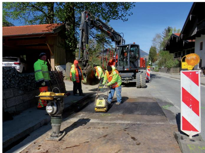
Die Asphaltierung des Leitungsgrabens soll im Jahr 2021 durchgeführt werden, da über den Winter mit Setzungen im Grabenbereich zu rechnen sind. Diese Maßnahme soll mit Beteiligung des Straßenbauamtes durchgeführt werden, welches weitere Bereiche der sanierungsbedürftigen Staatsstraße 2089 im Ortsbereich ebenso neu asphaltieren möchte.
